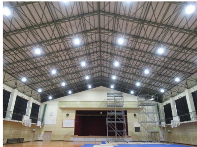
中学校体育館へのLED照明導入
