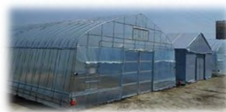
市で設置した2棟のビニールハウスと1棟の資材機具倉庫
