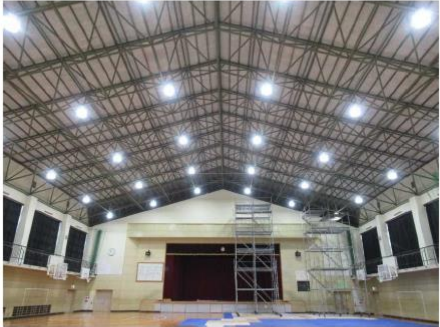
中学校体育館へのLED照明導入
