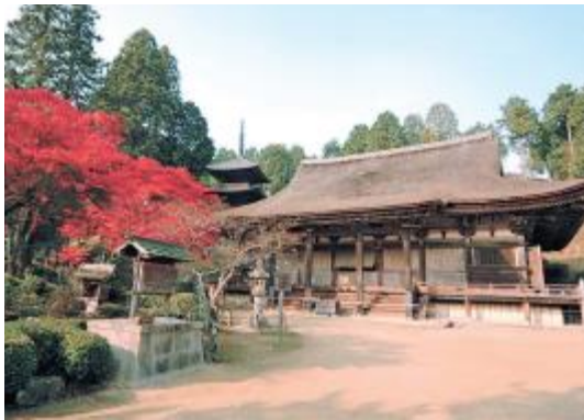
常楽寺本堂・常楽寺三重塔
