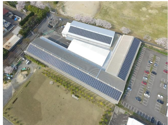
野洲川太陽光発電所
