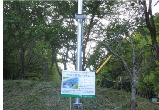
ピコ発電による外灯（LED 照明）
