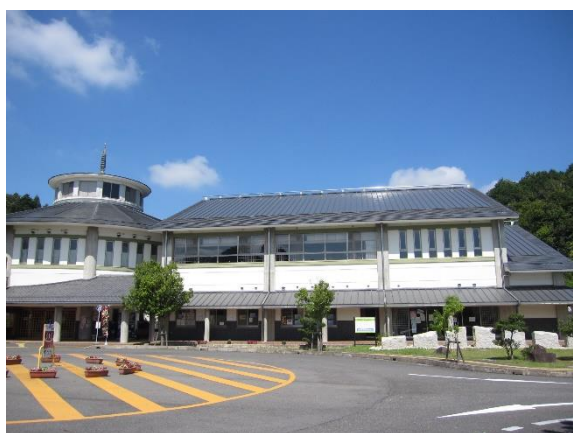
参号機 十二坊温泉ゆらら発電所
