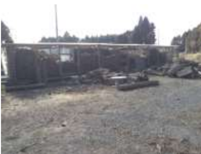
(土場内)薪の保管スペース
