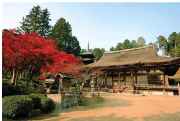
常楽寺本堂、常楽寺三重塔
