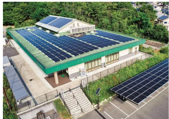
まちづくりセンターに設置している 太陽光パネル
