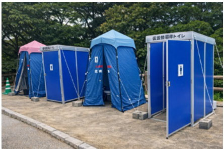
【マンホールトイレ】
