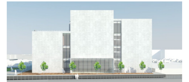
【西側立面：ガラス面を最小限に抑え熱負荷を低減】
