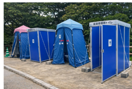
【マンホールトイレ】
