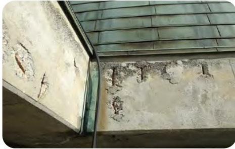
東庁舎4階軒部分
