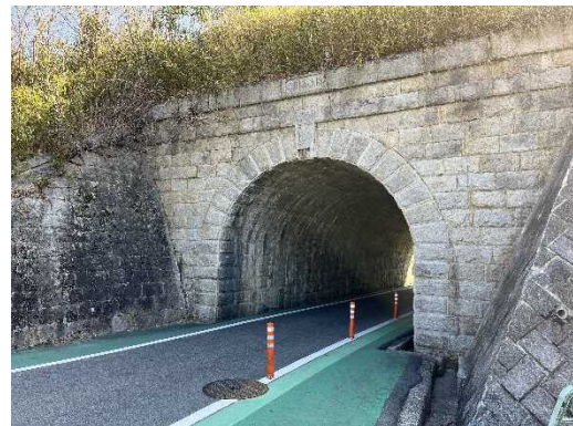
由良谷川隧道
