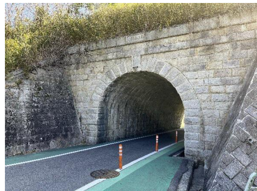
由良谷川隧道
