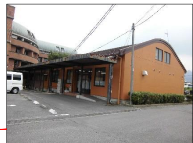
東庁舎（上下水道部）
