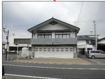
石部防災センター
