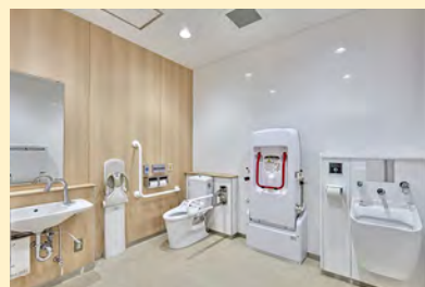
バリアフリー対応トイレ：江府町
