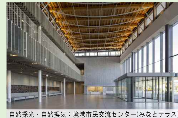
自然採光・自然換気：境港市民交流センター(みなとテラス)
