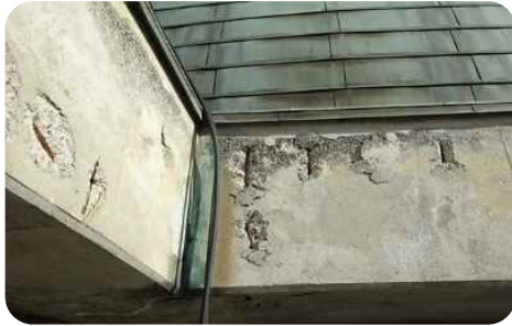
東庁舎 4 階軒部分
