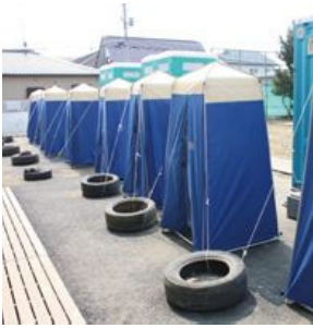
【マンホールトイレ】
