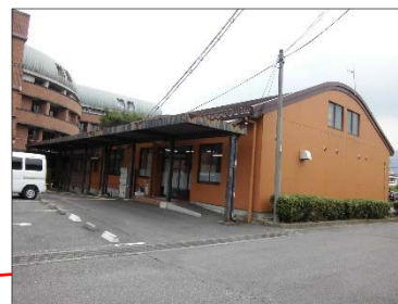
東庁舎（上下水道部）
