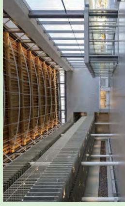
自然採光：自然換気：境港市民交流センター(みなとテラス)
