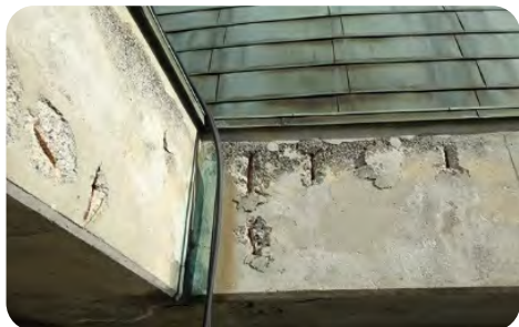
東庁舎 4 階軒部分
