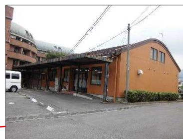
東庁舎（上下水道部）
