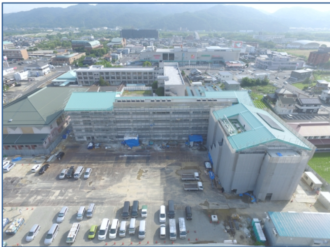
甲西中学校（耐震建替工事）
