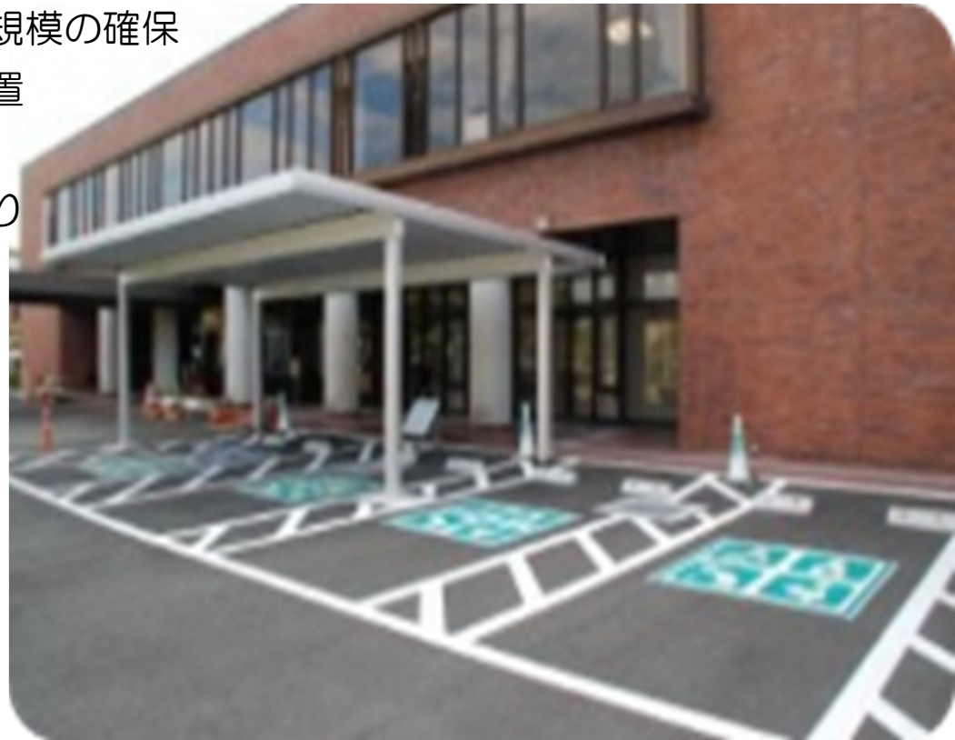
東員町：屋根付きハートフル駐車場
