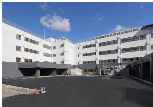
建替えが完了した石部小学校
