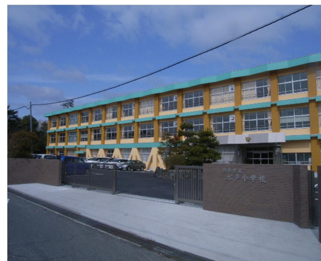
大規模改修が完了した水戸小学校
