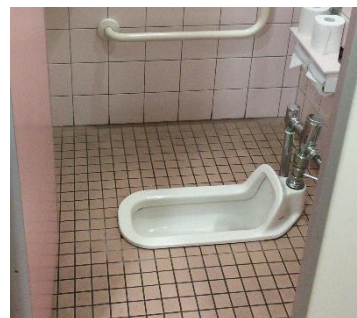
バリアフリー化されていないトイレ
