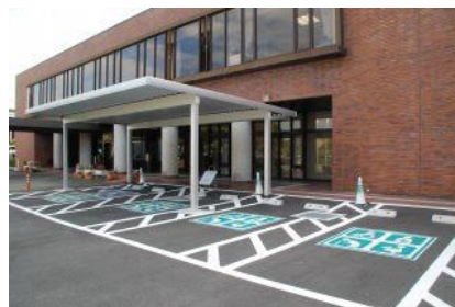
東員町：屋根付きのハートフル駐車場
